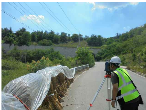
광파기를 이용한 측량 작업
